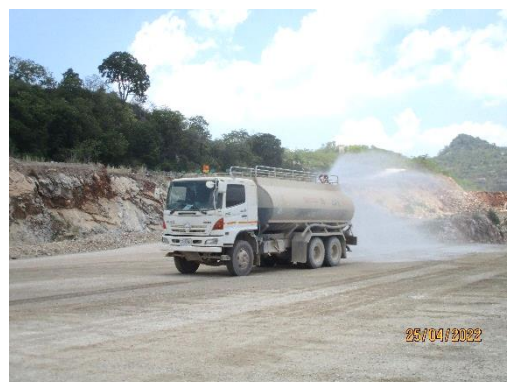
บดปรับพื้นที่เส้นทางถนน และรถบรรทุกฉีดพรมน้ำบนเส้นทางลำเลียง
