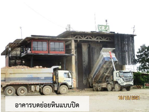
อาคารบดย่อยหินเป็นแบบปิดและติดตั้งระบบดักฝุ่นชนิด Bag Filter และม่านป้องกันฝุ่นฟุ้งกระจายเพื่อป้องกันฝุ่นออกสู่ภายนอก
