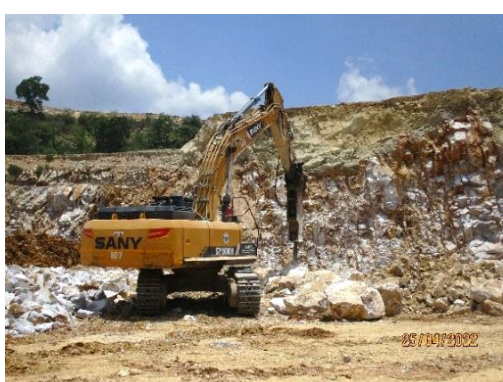
ทุบหินด้วย Hydraulic Breaker แทนการระเบิดย่อย
