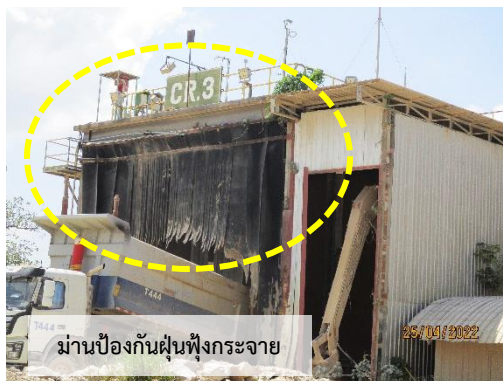
อาคารบดย่อยหินเป็นแบบปิดและติดตั้งระบบดักฝุ่นชนิด Bag Filter และม่านป้องกันฝุ่นฟุ้งกระจายเพื่อป้องกันฝุ่นออกสู่ภายนอก
