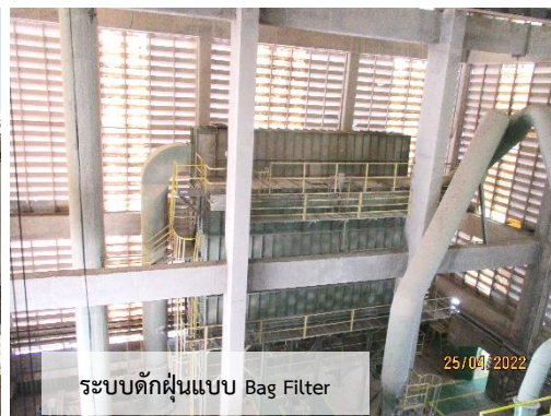
อาคารบดย่อยหินเป็นแบบปิดและติดตั้งระบบดักฝุ่นชนิด Bag Filter และม่านป้องกันฝุ่นฟุ้งกระจายเพื่อป้องกันฝุ่นออกสู่ภายนอก
