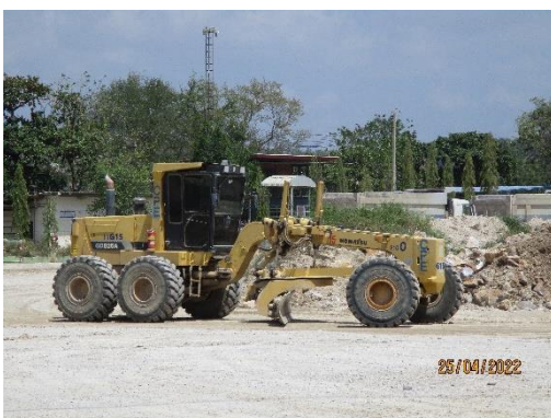
บดปรับพื้นที่เส้นทางถนน และรถบรรทุกฉีดพรมน้ำบนเส้นทางลำเลียง
